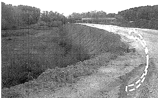
A Dunasor útra csatlakozó új bekötőút a palackozó üzemhez
