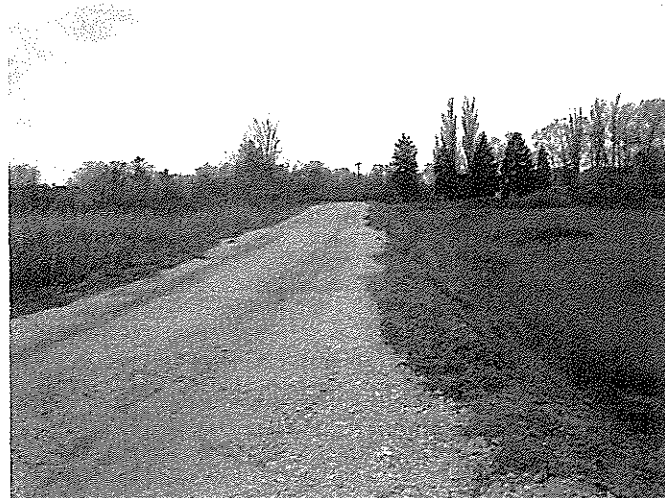
A Dunasor útra csatlakozó új bekötőút a palackozó üzemhez
